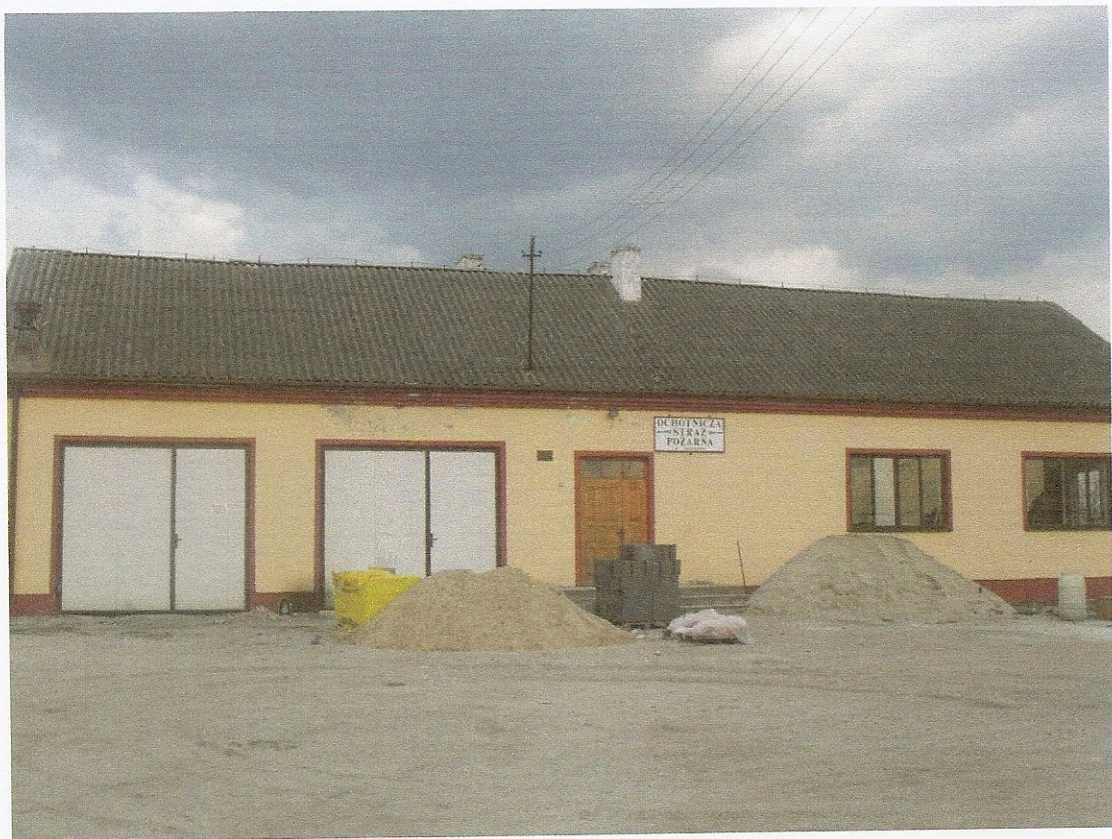
Budetak straży w czasie rozbudowy.
